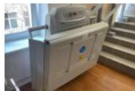
Влаштована платформа з похилим підйомом
