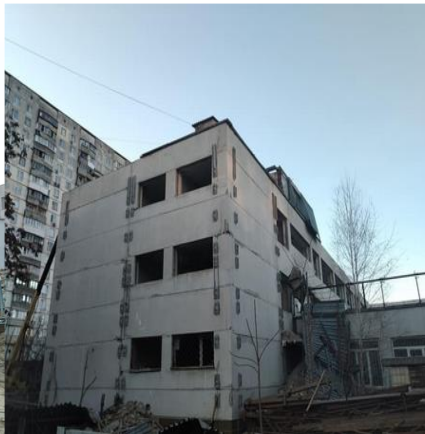
Реконструкція приміщення на Тичини, 17
